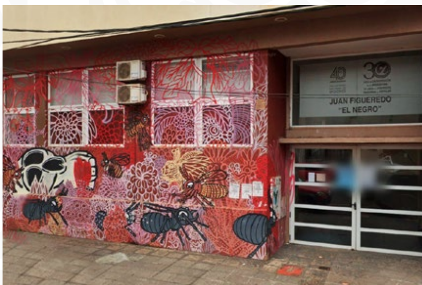
EDIFICIO JUAN FIGUEREDO FHYCS, UNAM
